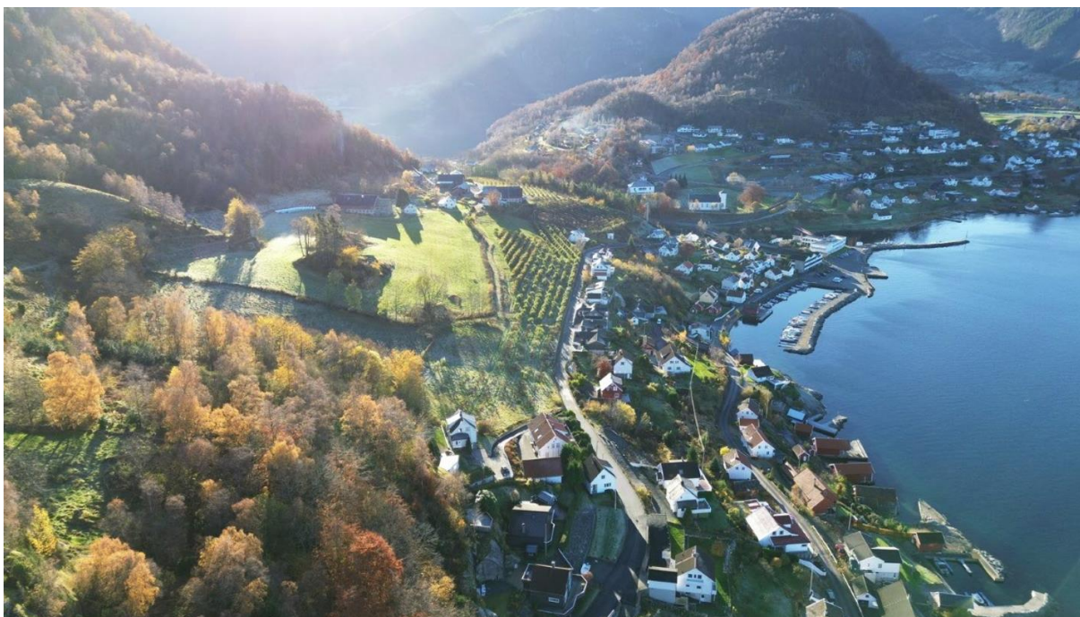
Figur 5-3: Dronebilde fra befaring.
